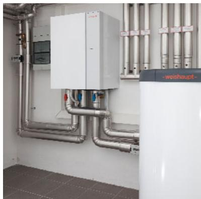
Innengerät und Trinkwasserspeicher im Keller
