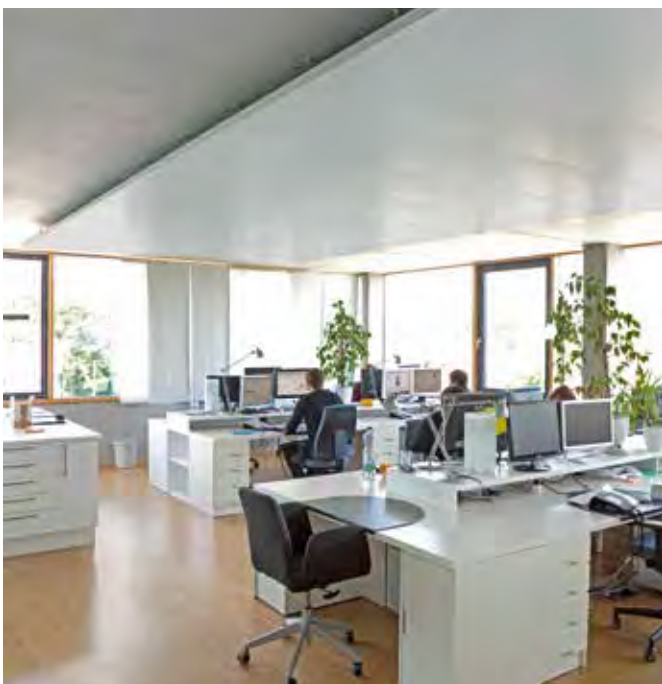
Metallsegel mit Aktivierung durch Graphit im Büroraum
