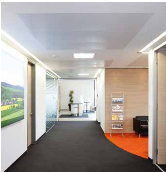
Geschlossene Metaldecke mit Aktivierung durch Aluminium im Flurbereich einer Bank
