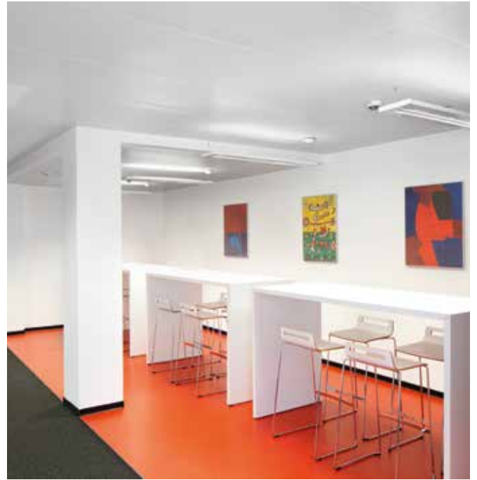
Geschlossene Metaldecke mit Aktivierung durch Graphit in der Cafeteria
