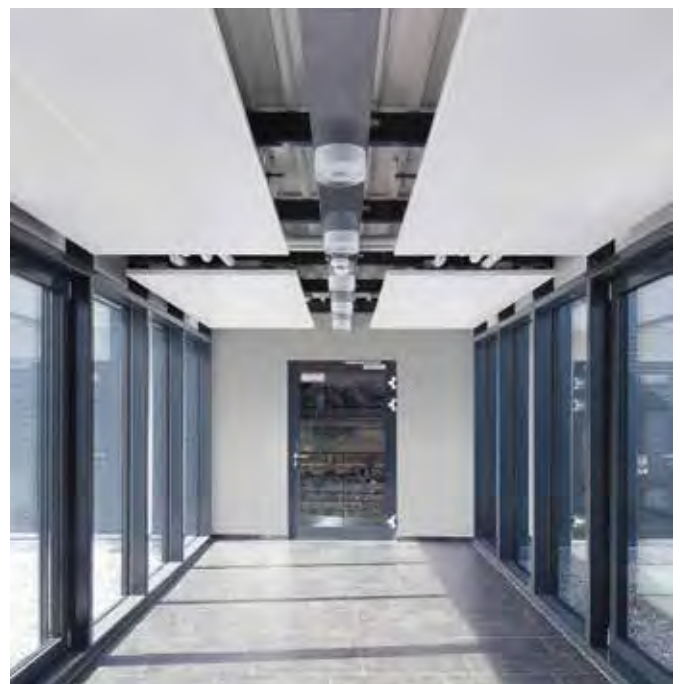
Metallsegel mit Aktivierung durch Aluminium im Durchgang eines Bürogebäudes
